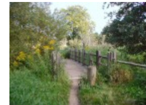
Brücke über Lietzengraben
